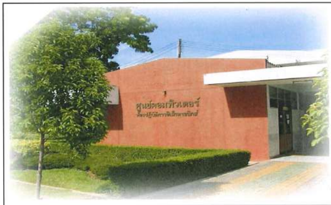
ภาพที่ 1 อาคารศูนย์คอมพิวเตอร์
