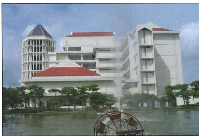
ภาพที่ 2 อาคารศูนย์ภาษาและคอมพิวเตอร์
